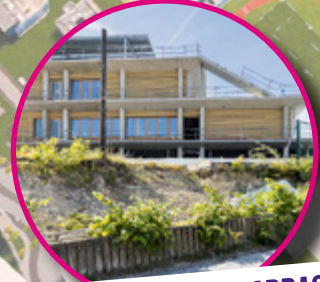
GROUPE SCOLAIRE D'ARRAS
