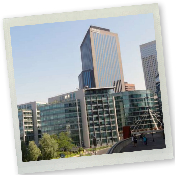
L'extension de La Défense hors de la dalle le quartier du Faubourg de l'Arche
