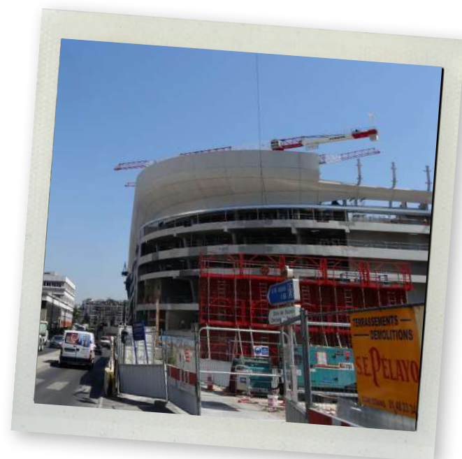
Travaux du stade Arena
