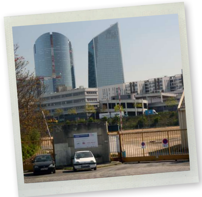
Site de la future gare Nanterre-la-Folie
